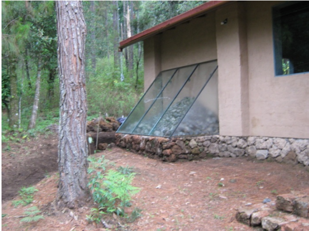
Muro calefactor construido en Terreno Viva
