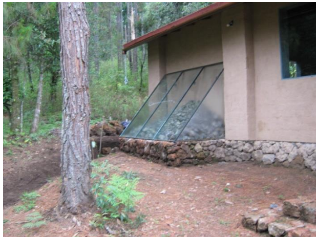
Muro calefactor construido en Terreno Viva
