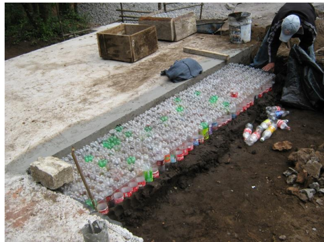
Gráfica 3: Uso de distintos materiales para aislamiento térmico previo al firme en la casa del velador en terreno Viva.
