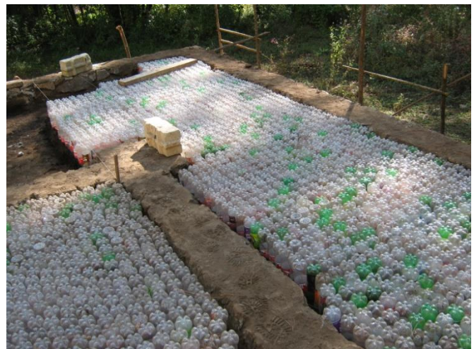
Gráfica 3: Uso de distintos materiales para aislamiento térmico previo al firme en la casa del velador en terreno Viva.
