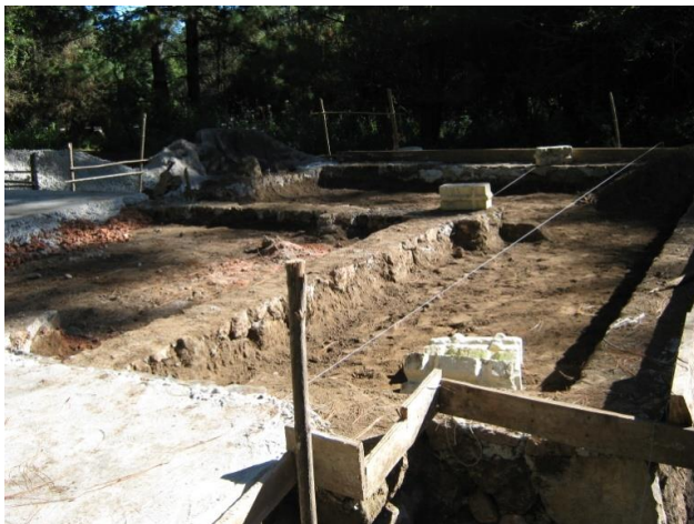
Gráfica 3: Uso de distintos materiales para aislamiento térmico previo al firme en la casa del velador en terreno Viva.
