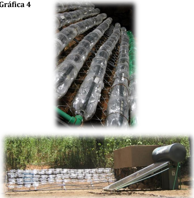
Calentador solar de agua con botellas PET en Centro Viva , (en primer plano está el calentador de agua tipo comercial)
